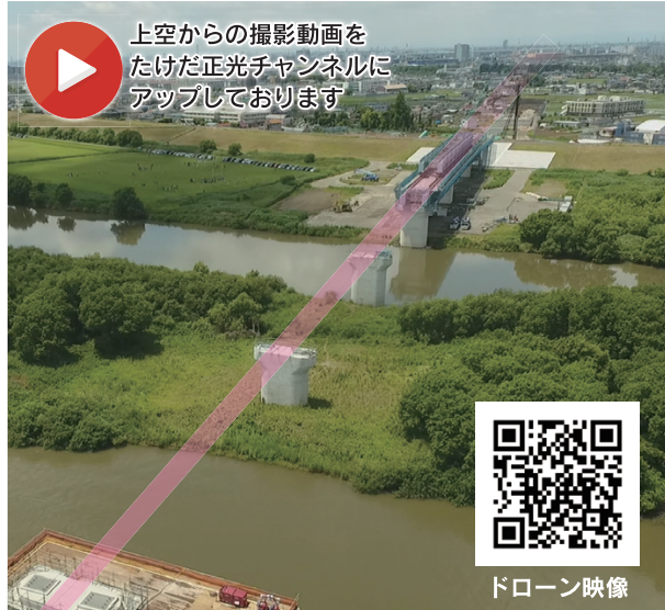
上空からの撮影動画をたけだ正光チャンネルにアップしております ドローン映像 (仮称)三郷流山橋の工事状況 橋脚・橋台 全25基中 18基完成 7基工事中
