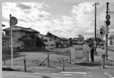
12月 三郷流山橋 整地工事現場にて
