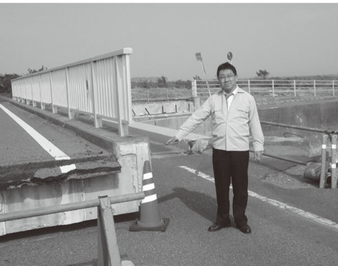
震災視察 津波で流された橋が別の橋の上に乗っている(千葉県旭市)
